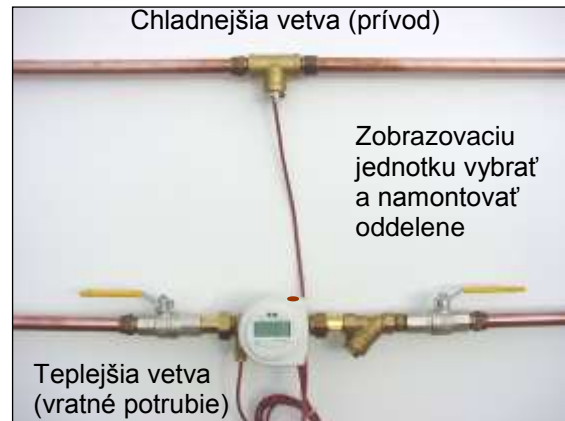
Obr. 2: PolluCom EX/S v chladiacom systéme
